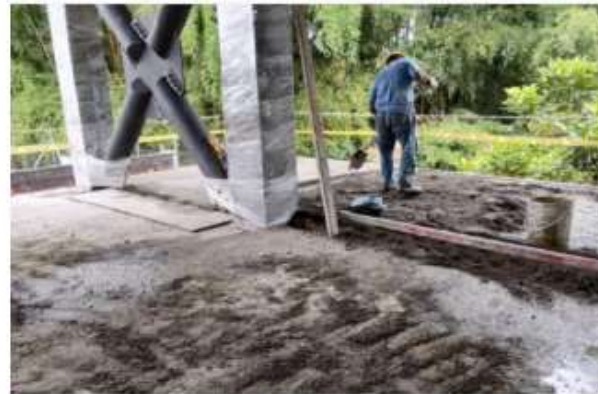
Alistado en mortero para enchape nivel mezanine
