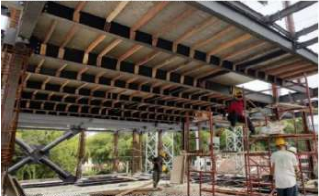
Armado tableros en placa piso 2 costado oriental
