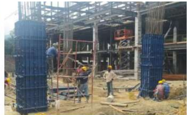
Formaleta metálica para fundida de columnas
