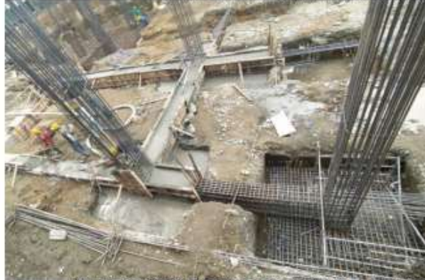
Avance proceso de armado y fundida dados y vias cimentación T2
