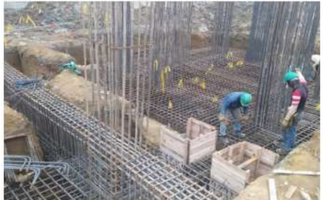
Armado hierro refuerzo dados y vias cimentación en Ascensores T2
