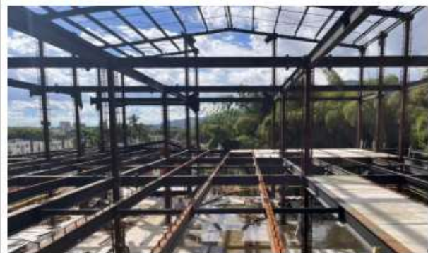
Entrega estructura metálica piso 3 para placa, pendiente Ej 1 a 2
