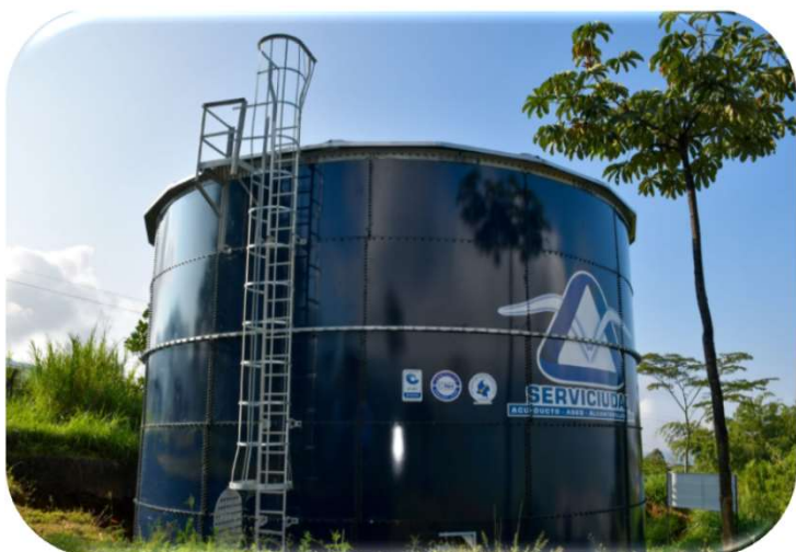
TANQUE EL RODEO - 750 M3
