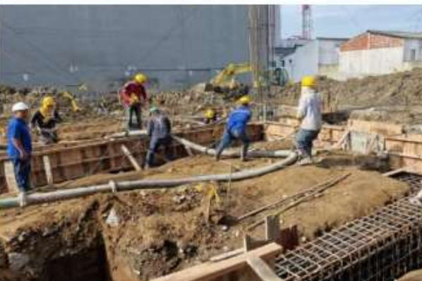
Fundida de dados y vias de cimentación
