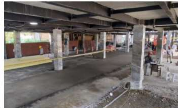
Alistados mortero para enchape en placa contrapiso Torre 1
