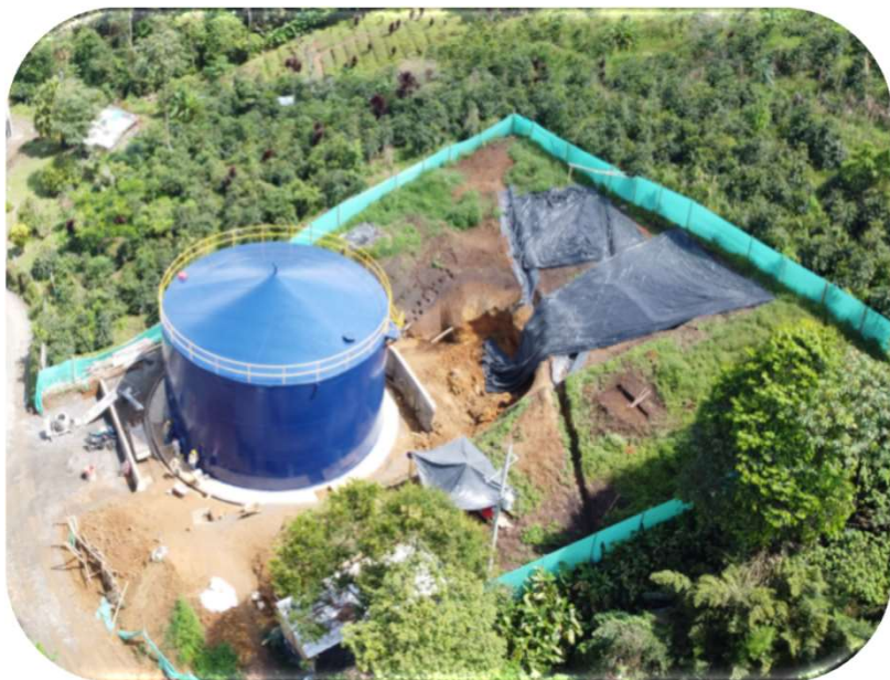
TANQUE LA DIVISA 1.200 M3
